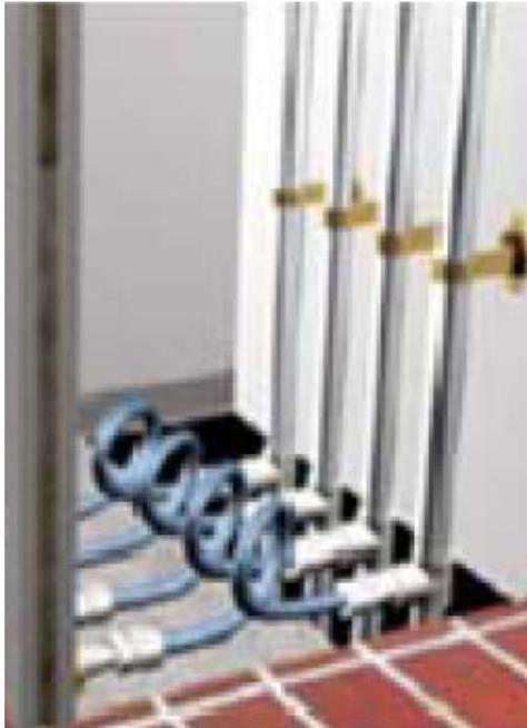
Figura GP-03. Conectores flexibles de conexión con los montantes verticales.
