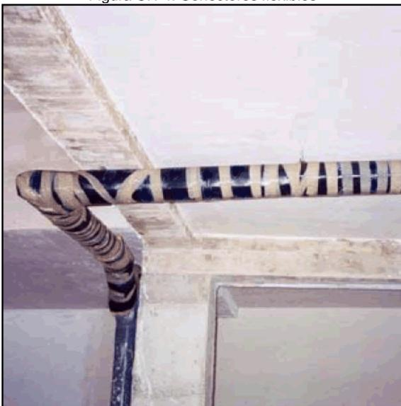
Figura CH-6. Aislamiento de colector de evacuación
