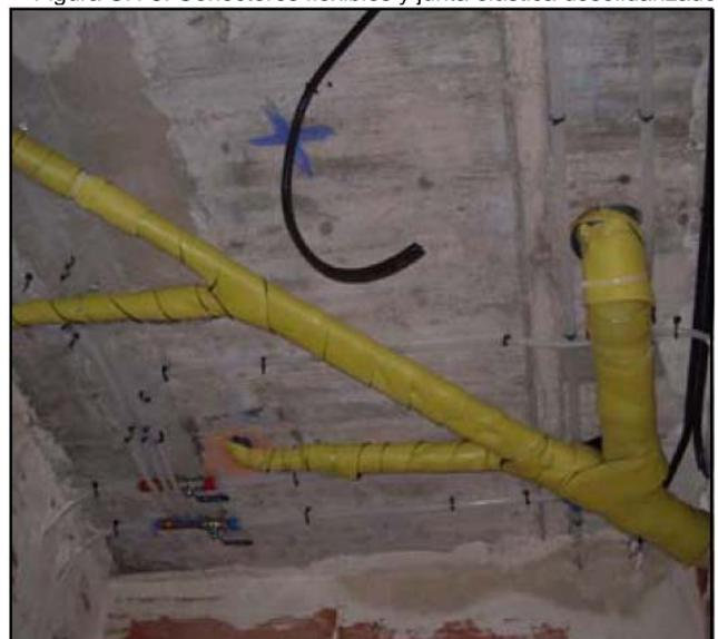
Figura CH-7. Aislamiento de pulpo de desagüe
