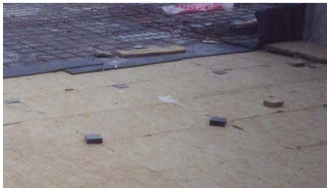
Figura R\_INST-02. Ejemplo de un suelo flotante
