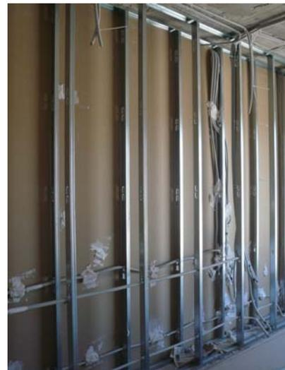
Detalle ESV-03.b.V3. Instalación incorrecta de las instalaciones. Deben evitarse los contactos rígidos entre las hojas de las placas
