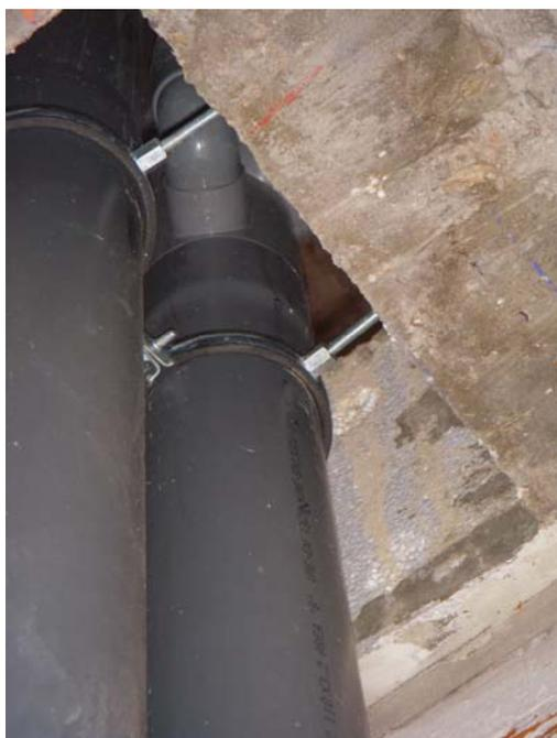
Figura CP-06. Anclaje de bajante a canto de forjado y uso de abrazaderas desolidarizadoras.
