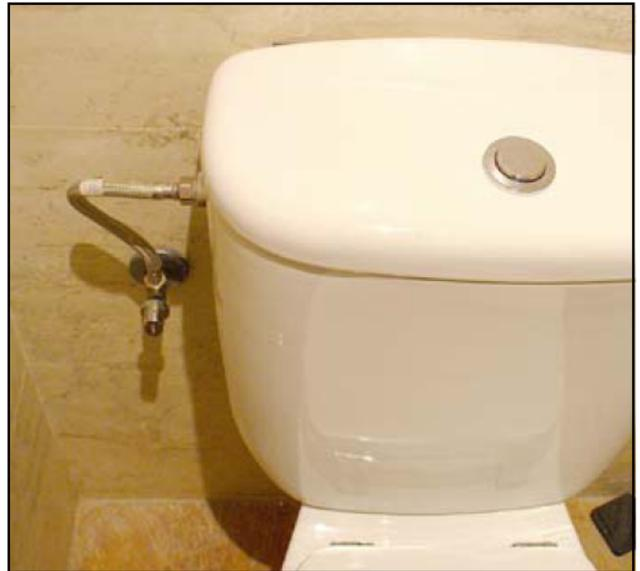
Figura CH-5. Conectores flexibles y junta elástica desolidarizadora
