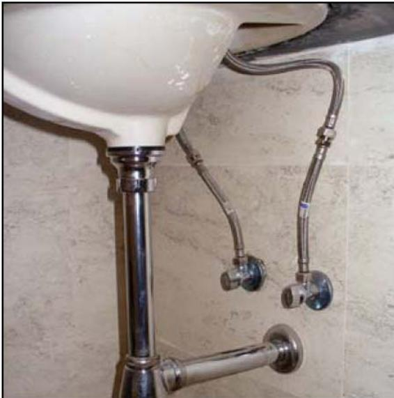
Figura CH-4. Conectores flexibles
