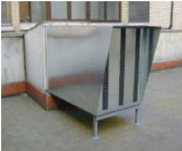
Figura CAL-06. Ejemplo de un silenciador
