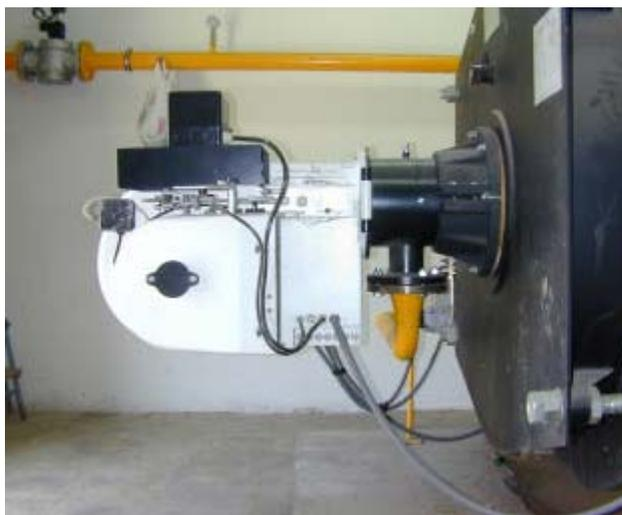
Figura CAL-02. Ejemplo quemador sin encapsular
