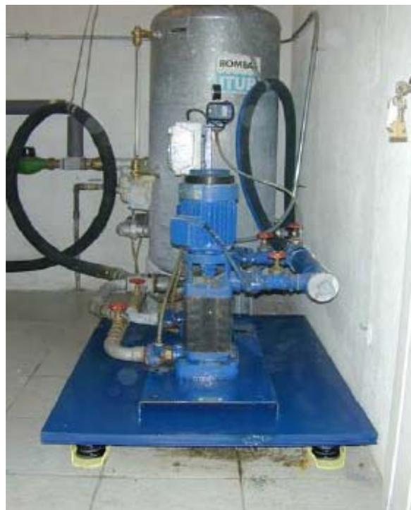
Figura GP-05. Ejemplo bancada de inercia bajo grupo hidroneumático, con amortiguadores bajo bancada y conectores flexibles a la entrada y salida de las tuberías a las bombas.
