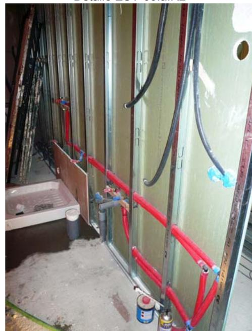
Detalle ESV-03.a.R3. Instalación correcta de las tuberías entre los perfiles de las placas de yeso laminado.
