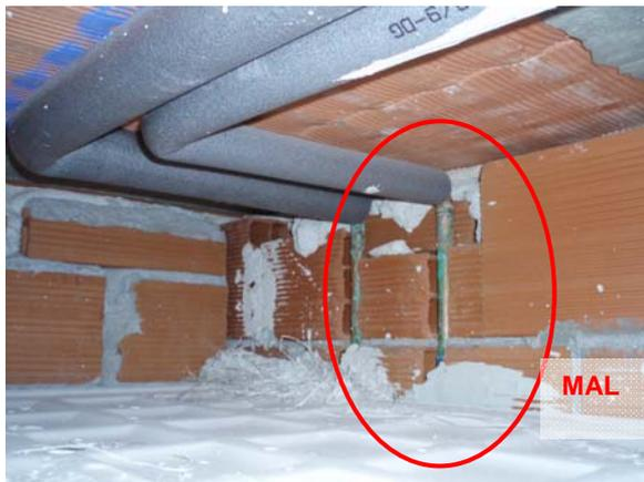
Figura CH-3. Detalle de tuberías empotradas en la partición sin retacar en una partición sin revestir en el espacio que queda por encima del falso techo.
