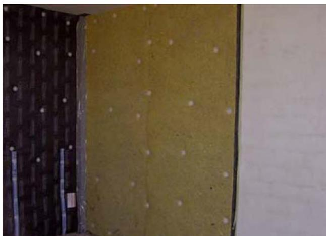
Figura R\_INST-05. Ejemplo de un trasdosado
