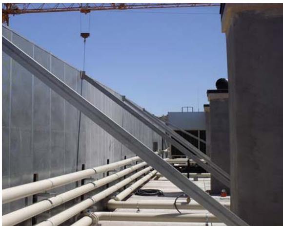
Figura 03. Colocación de tirantes para la sujeción de de pantallas
