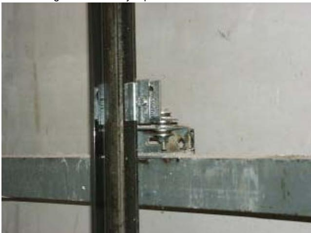
Figura ASC-04. ejemplo de anclaje de guías
